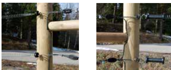
Bilde 16 og 17. Montering fjærgrind.
